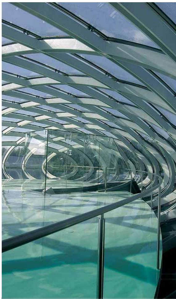
"Bolle" — Nardini Distilleries — Центр исследований и мероприятий — Бассано дель Граппа, Италия — Архитектор: M. Fuksas — Sunergy Clear & Planibel Green
