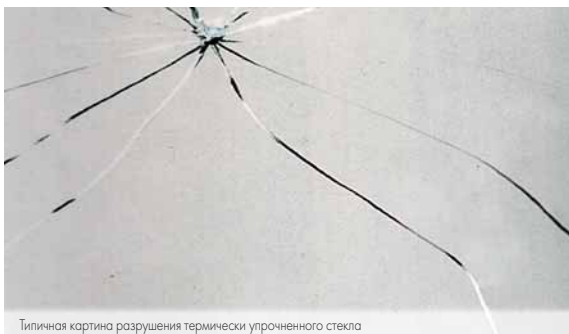
Типичная картина разрушения термически упрочненного стекла
